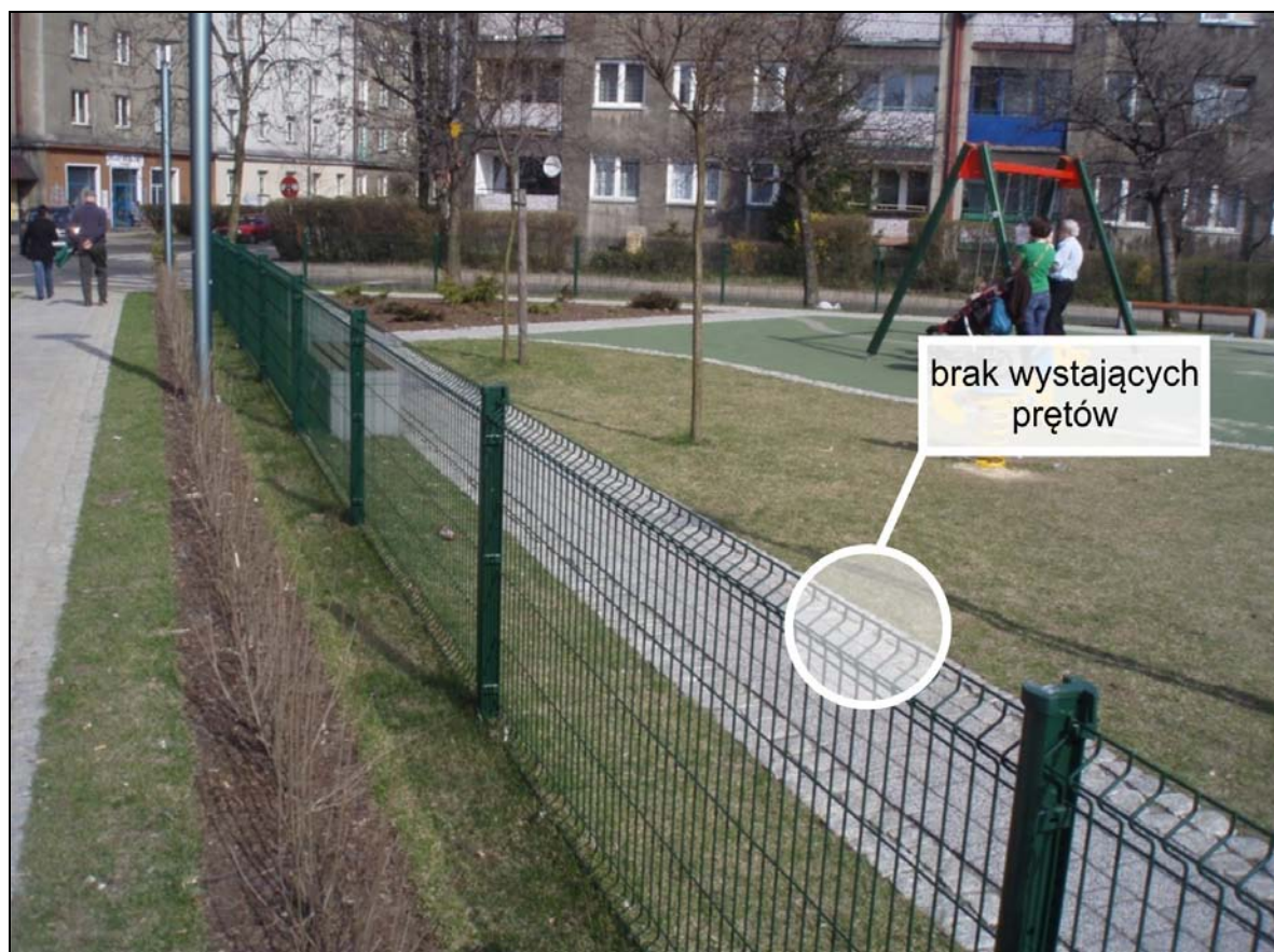
Rys.16 Projektowany typ ogrodzenia panelowego (zaznaczono miejsca gdzie absolutnie nie mogą występować pionowe pręty).
