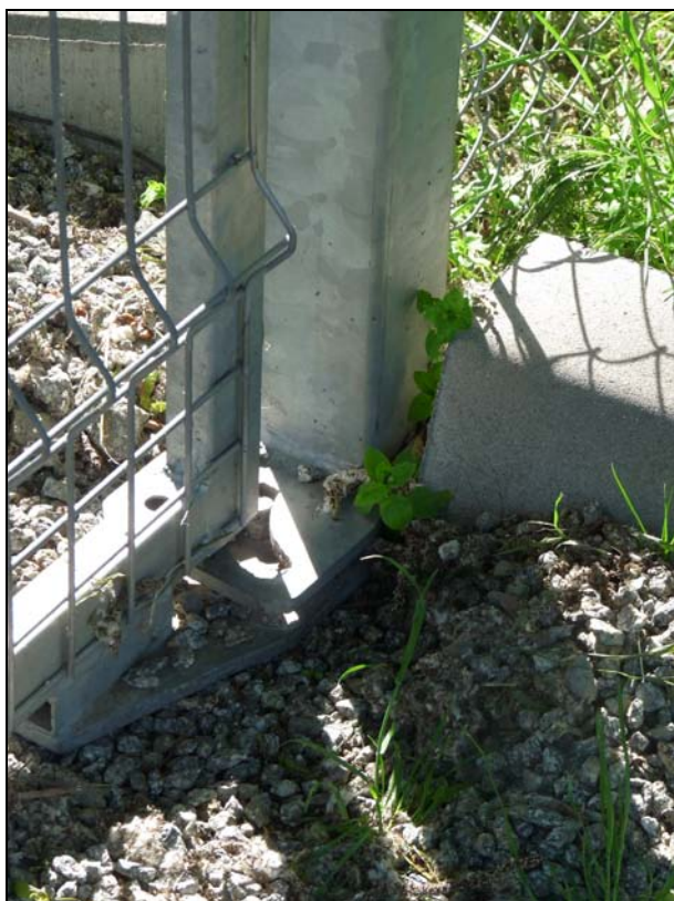
Rys. 17 Proponowany system samozamykacza w furtce. Widoczny dolny zawias większego skrzydła furtki, który pozwala na bezpieczne samozamknięcie skrzydła pod naporem pionowym własnego ciężaru. (tu na ilustracji tylko ocynkowana, ma być malowana proszkowo)
